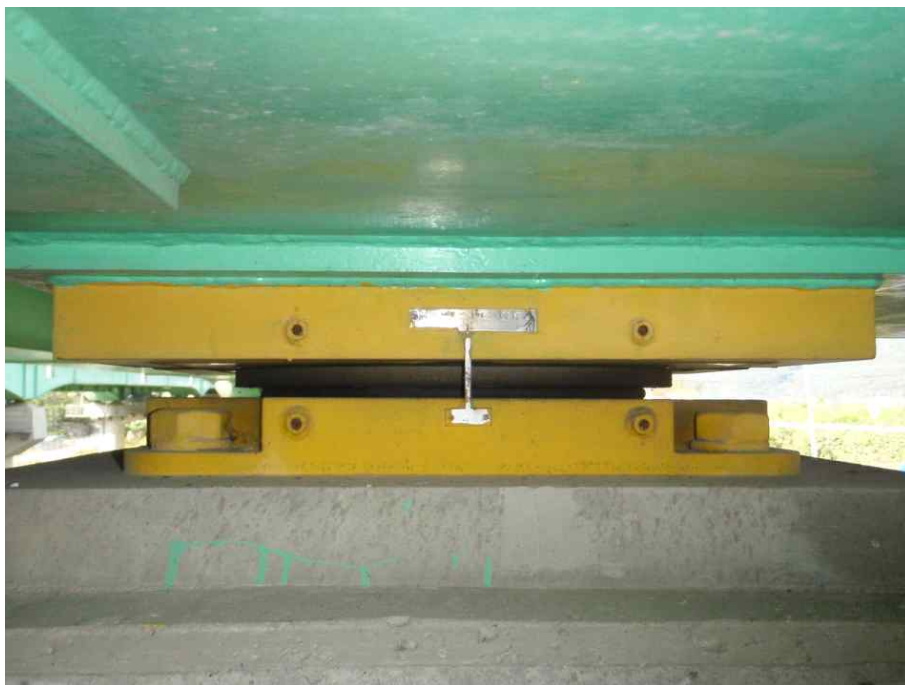
받침장치 전경 (가동단)
