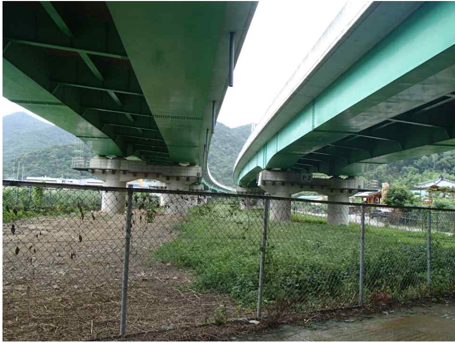
Steel Box Girder 외부 전경
