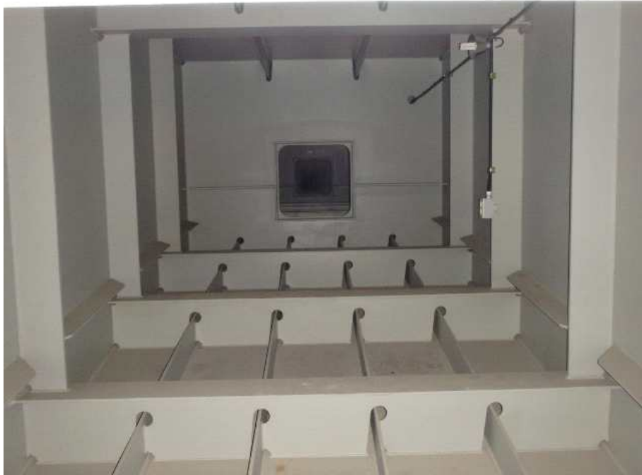
Steel Box Girder 내부 전경
