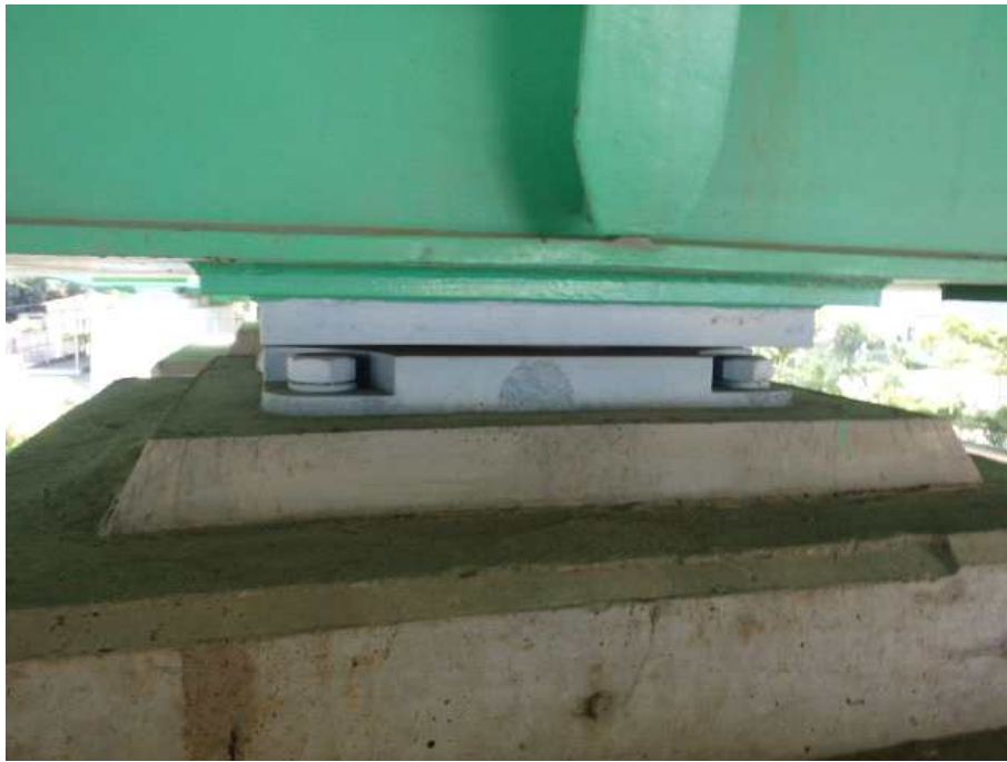
받침장치 전경 (고정단)
